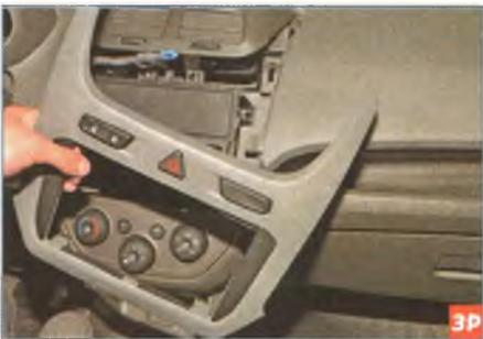
Снимаем центральную накладку панели приборов с выключателями (см. «Снятие выключателей и регуляторов», с. 222).
